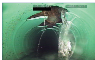
► Cracks or breaks
