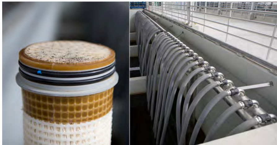
Water Factory 21- 326 ML/d (26 x Memcor ® CS608)
