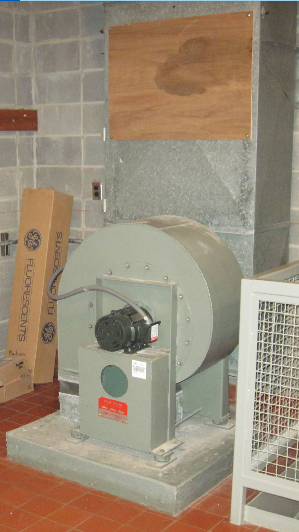
Existing Supply Fan
